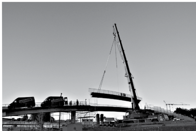
Ein Pneukran hebt ein Brückenelement an
